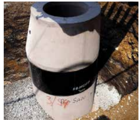
Fairchance Borough, Pensilvania, EUA Fosos de visita prefabricados • Bio-San C500
